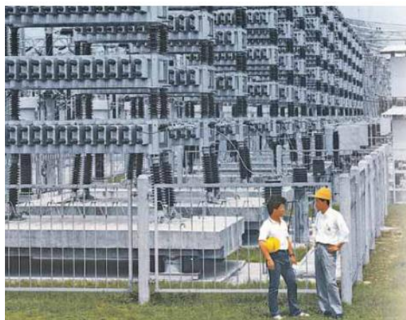
شکل (۲-۷۰): شمای ظاهری فیلترهای AC در پست Gezhouba کشور چین
