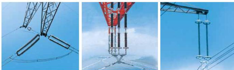
شکل (۲-۸): ایزولاتورهای خطوط HVDC به ترتیب از راست به چپ: یکپارچه پلیمری، یکپارچه چینی و مقره بشقابی
