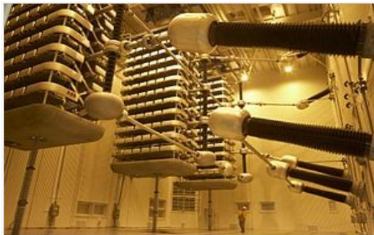
شکل (۱-۴): HVDC از نوع ولو تریستوری بین جزایر شمال و جنوب نیوزیلند
