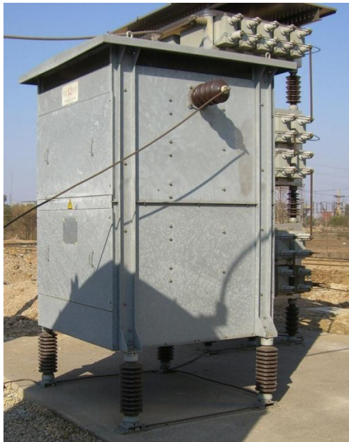
شکل (۲-۹۳): بانک مقاوت مورد نیاز در فیلترها
