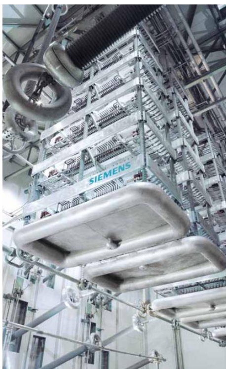
شکل (۲-۶۴): شمای فیزیکی یک نمونه برج ولو ساخت شرکت زیمنس
