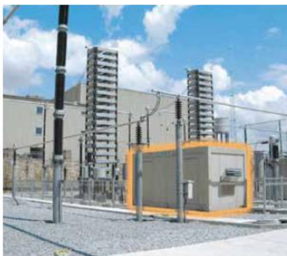
شکل (۲-۷۴): فیلتر فعال DC در پست Tian Guang در کشور چین
