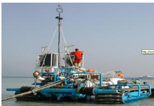
شکل (۲-۴۲): نمای ربات مخصوص خوابانیدن کابل در بستر دریا
