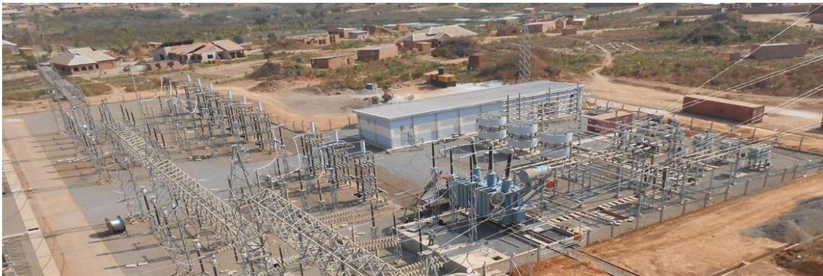
شکل (۱-۷): نمای فیزیکی تجهیزات پست انتقال و SVC احداث شده در آن
