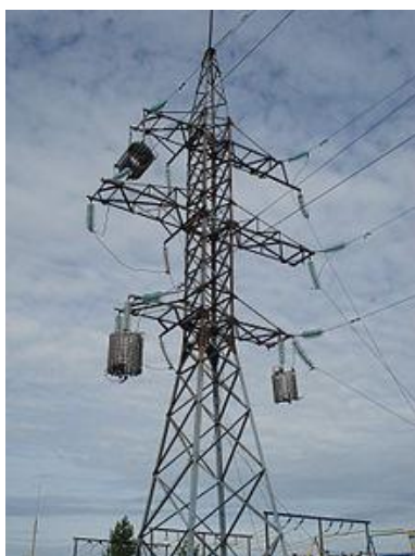
شکل (۲-۵۸): تله موج کار گذاشته شده در مسیر خط انتقال
