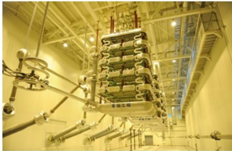
شکل (۴-۱): ولو تریستوری خطوط انتقال HVDC
