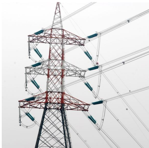
شکل (۲-۱۹): خط انتقال دومداره
