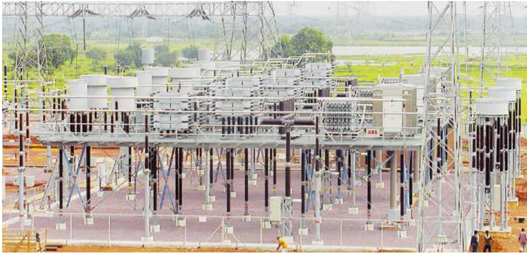
شکل (۱-۶): شمای فیزیکی یک TCSC در شبکه برق هندوستان
