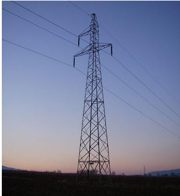
شکل (۲-۱۸): خط انتقال تک‌مداره
