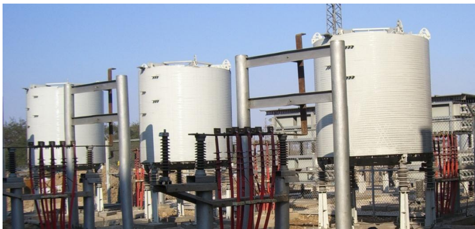
شکل (۲-۹۴): راکتورهای فیلتر
