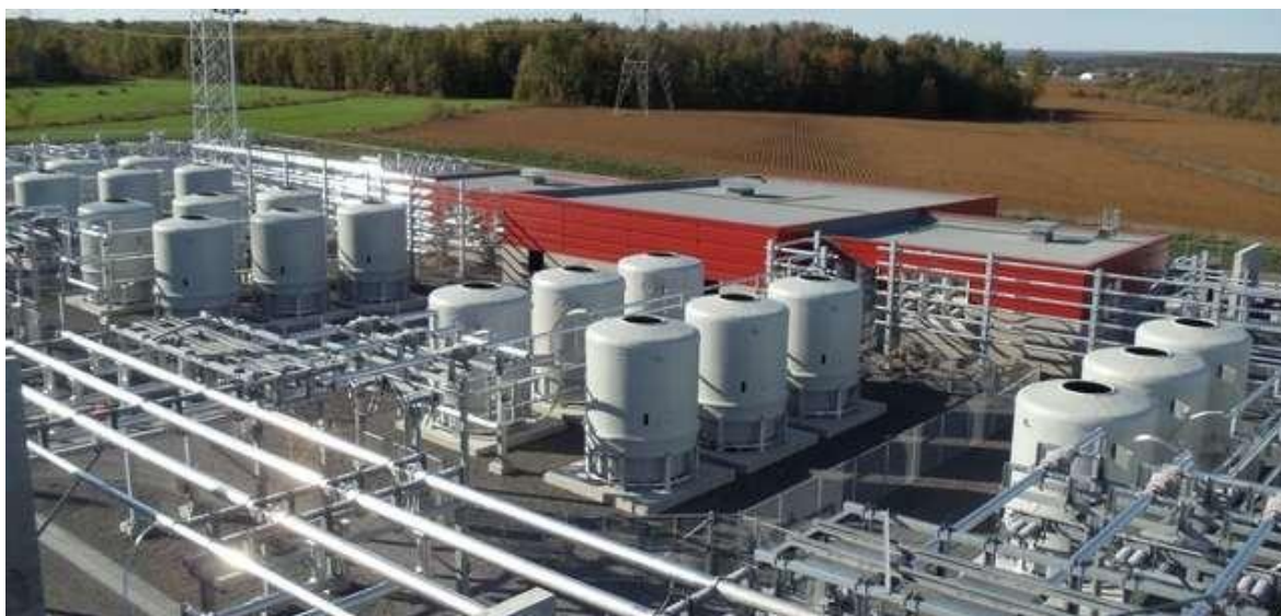
شکل (۱-۸): نمای فیزیکی SVC واقع در شهر کبک کانادا
