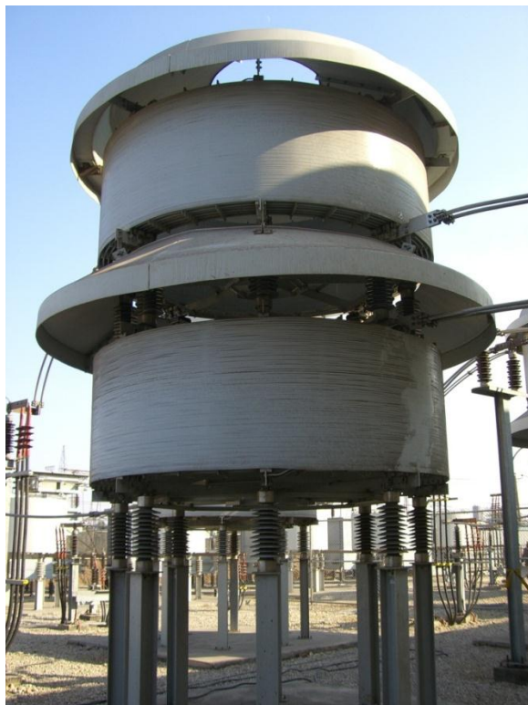
شکل (۲-۹۱): راکتور TCR یک SVC
