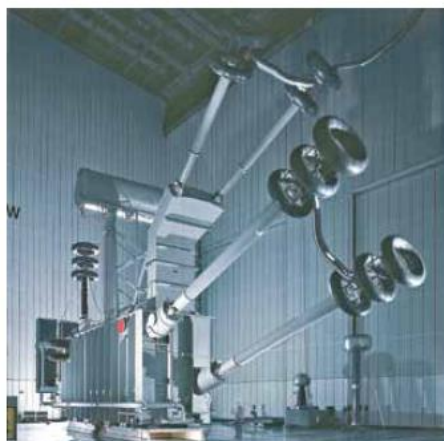
شکل (۲-۱۰۵): ترانسفورماتور مبدل پروژه Tian Guang کشور چین در حال انجام تست در آزمایشگاه
