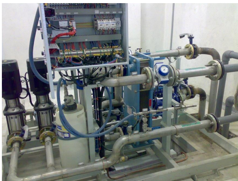
شکل (۲-۹۷): تجهیزات سیستم خنک سازی ولو
