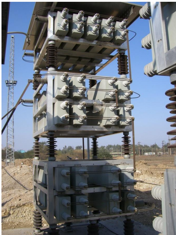
شکل (۲-۹۲): بانک خازنی فیلترهای یک SVC
