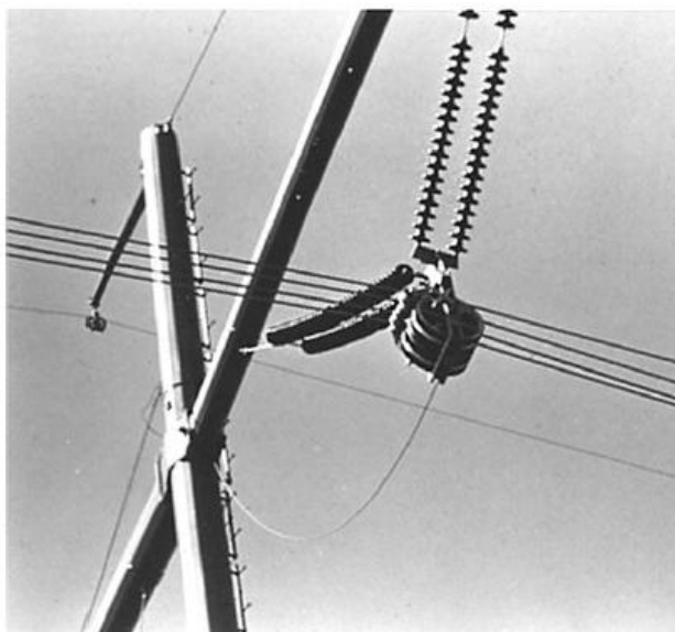
شکل (۲-۳۸): نحوه اتصال پولی و اتصال زمین
