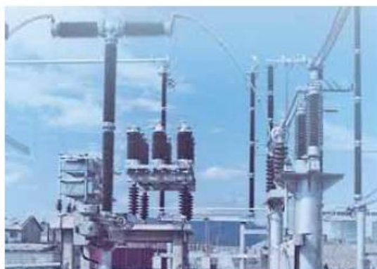
شکل (۲-۵۲): کلید MRTB در سوئیچگیر DC در Tian Guang کشور چین
